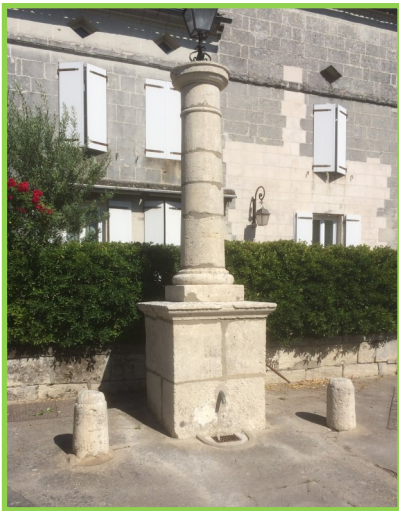
Nettoyage de la pompe carrefour St Genis / Consac
