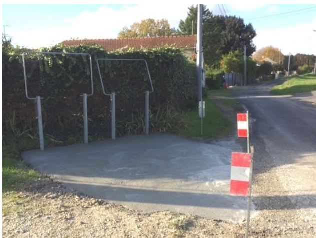
Travaux d'aménagement des plateformes des bacs jaunes et verts sur toute la commune.
